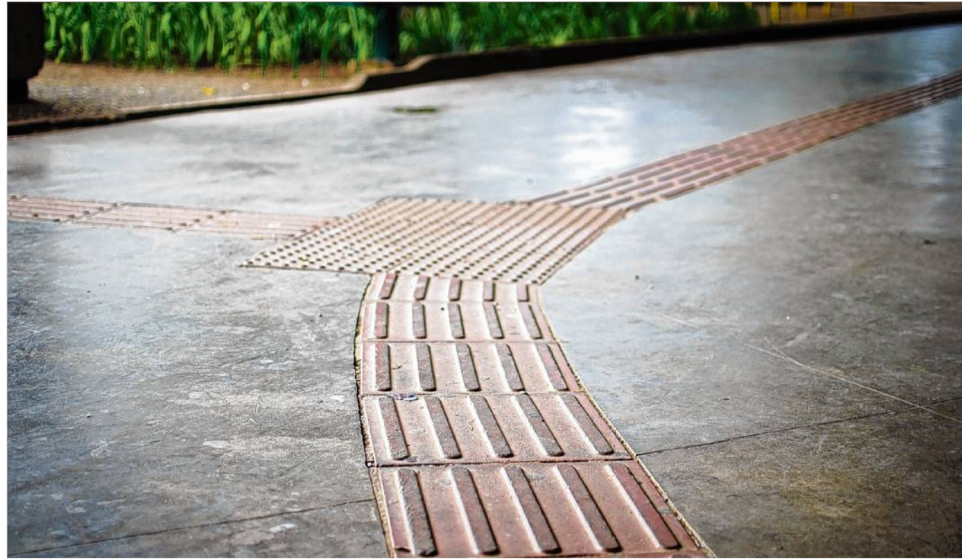
Ein gutes Beispiel, um Barrieren abzubauen: Ein taktiles Leitsystem erleichtert Menschen mit einer Sehbehinderung die Orientierung. Archivfotos: ILE-Regionalmanagement/Klaus Lindemann/Wittlager Kreisblatt
