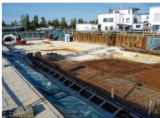
Direkt neben dem Marinabecken in Bad Essen wird wieder gearbeitet. Foto: Hubert Dutschek
