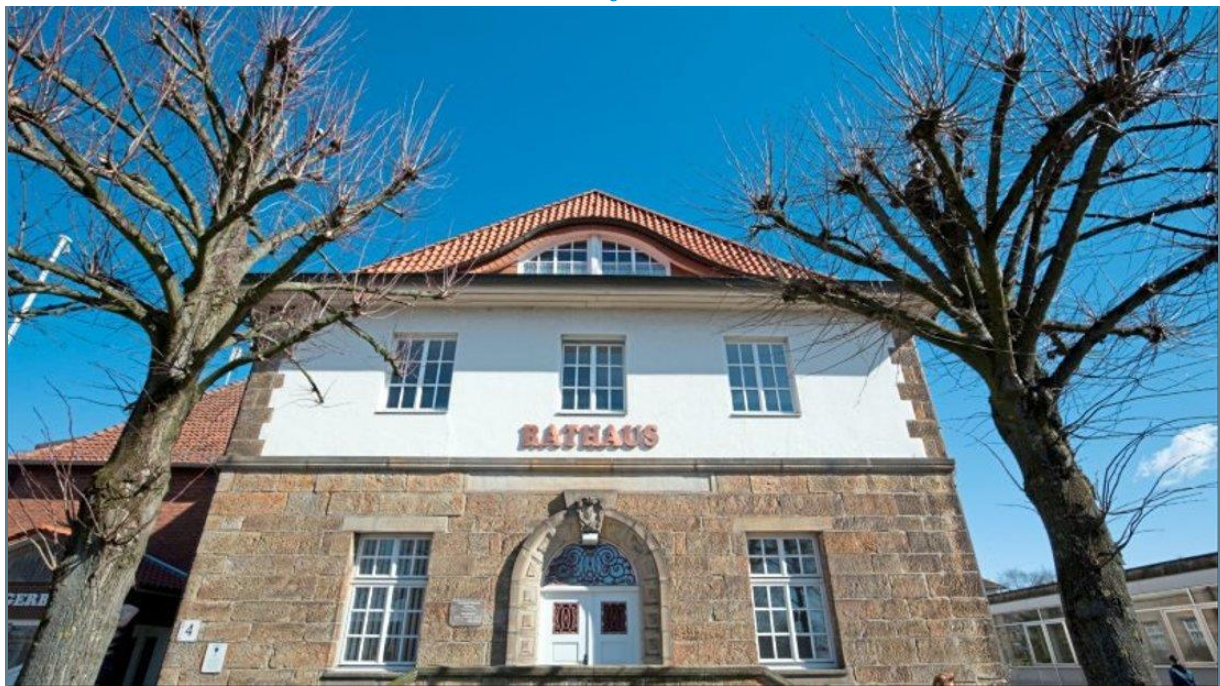
Barrierefreiheit in Bohmte: Die oberen Geschosse des Rathauses Bohmte sollen zukünftig über einen Aufzug erreichbar sein. Foto: Oliver Krato
